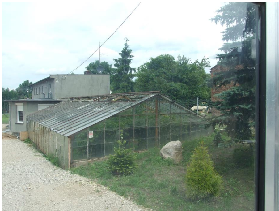
Fot. 1. Budynek mieszkaniowy i szklarnia zlokalizowane na działce nr 61 w pasie przyulicznym ulicy Józefa Poniatowskiego.
