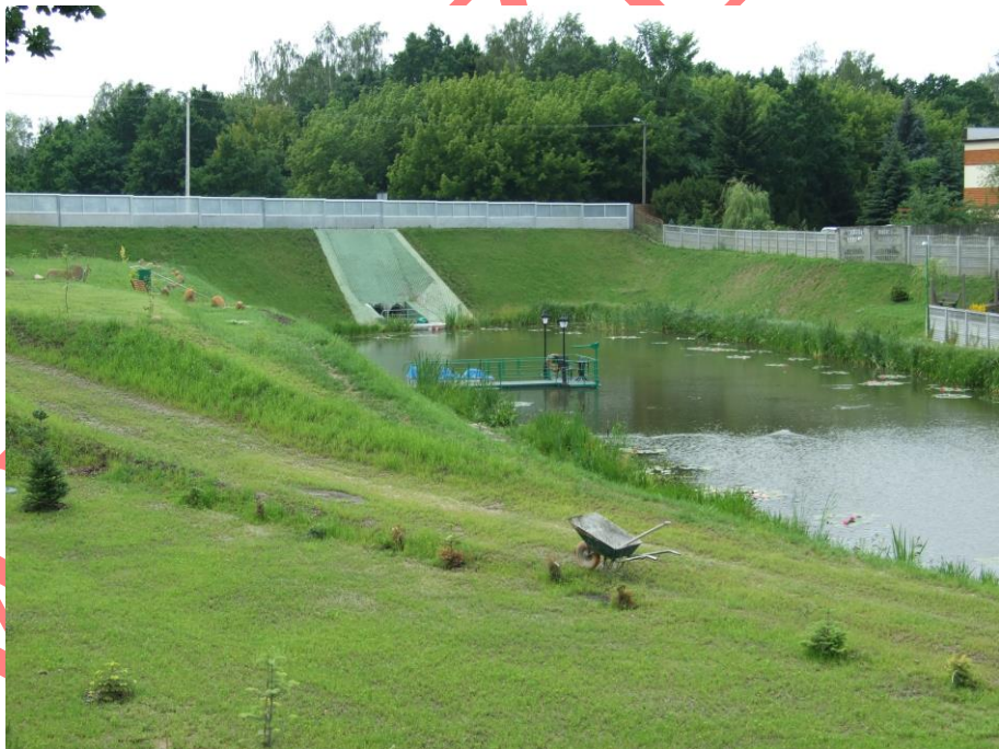
Fot. 3 i 4. Fragment działki nr 61. W głębi widoczny ekran akustyczny – przegroda pomiędzy pasem drogowym ul. J. Poniatowskiego, a przedmiotową działką.
