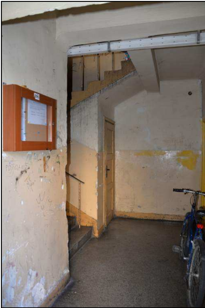
Fot. Klatka schodowa przy ulicy Sienkiewicza
